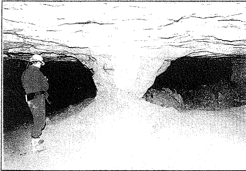
Photo n° 2 : Exemple de cavités dans les sables.
