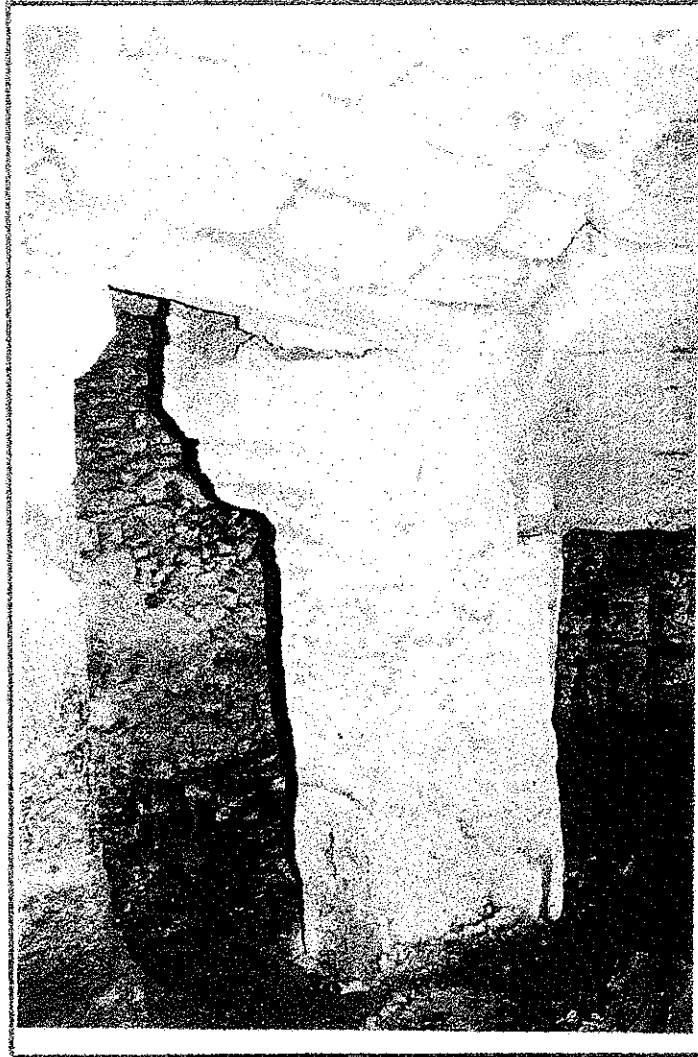
Photo n° 5 : Rupture par décollement d'un pilier sous-miné par une cavité dans les sables.
