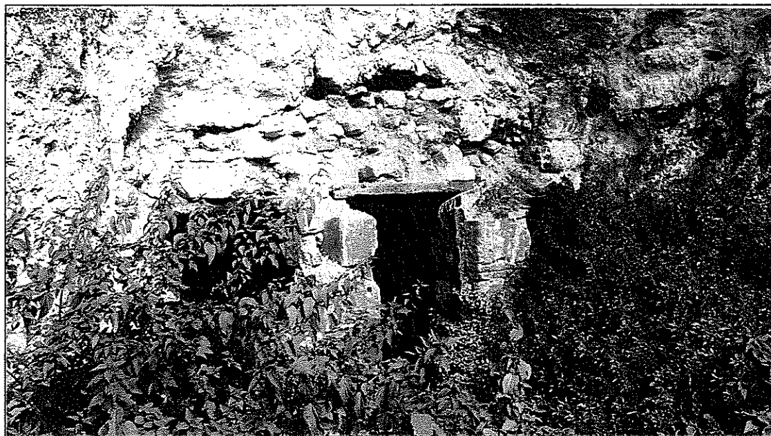
Photo n° 7 : Ancien écroulement de rempart revégétalisé (Nord de la Porte de Soissons).
